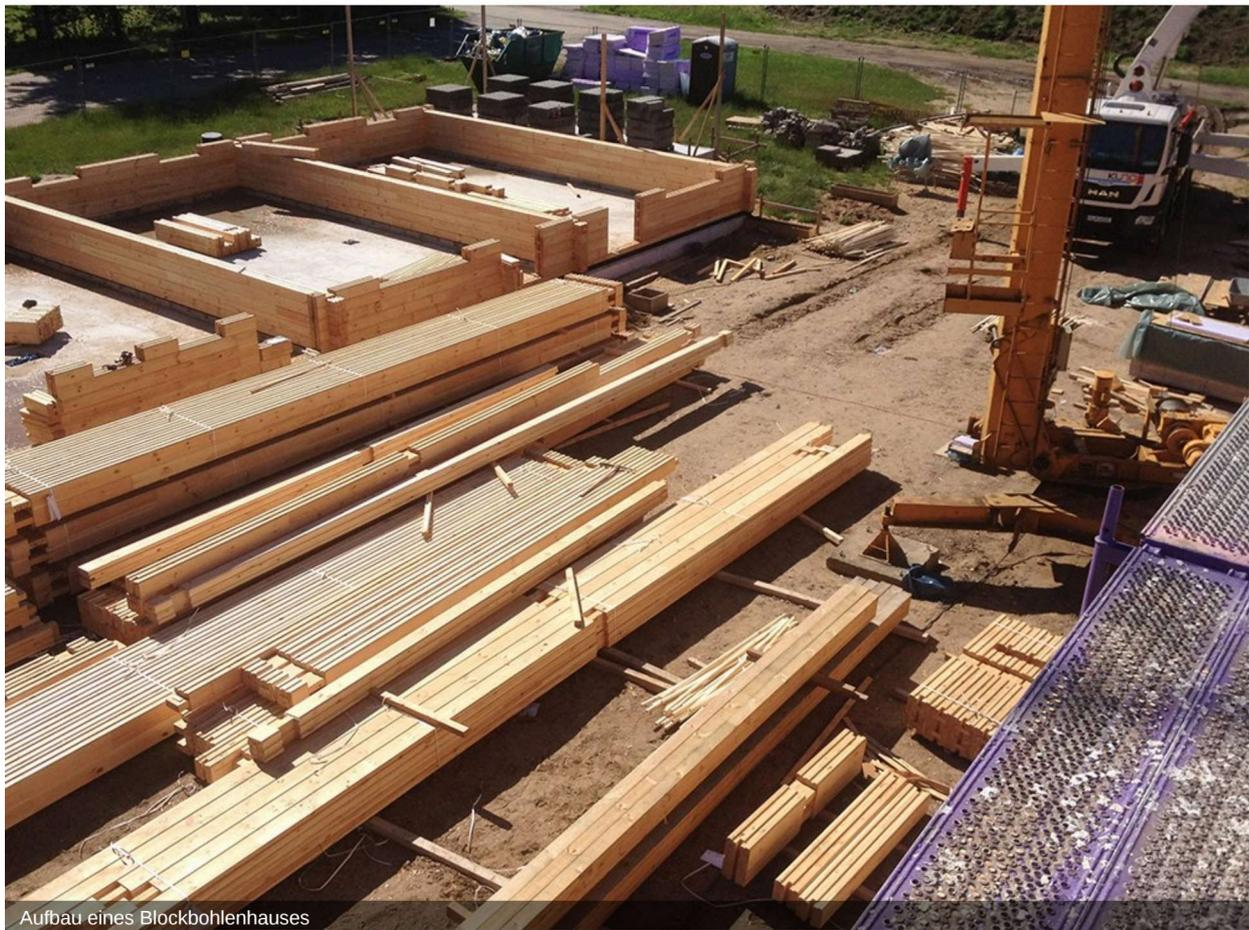
Aufbau eines Blockbohlenhauses
